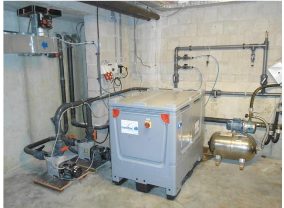
Box met elektrolysecel voorraadvat en regelapparatuur
